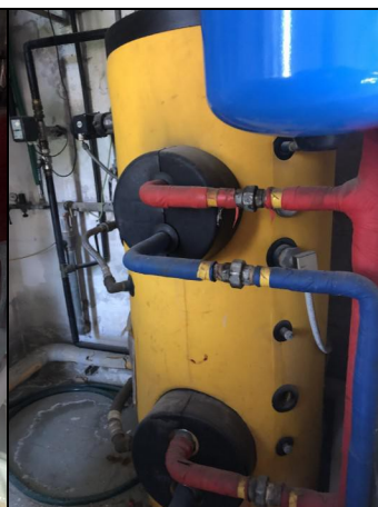
Impianti - Boiler per acqua calda sanitaria
