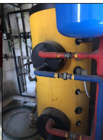
Impianti - Boiler per acqua calda sanitaria
